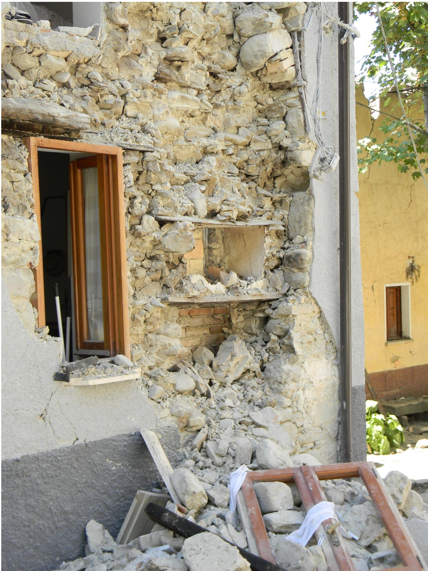
Nicchie a interruzione della continuità strutturale.
